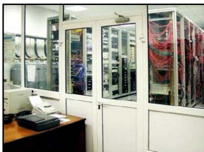
Вход в Дата-Центр
